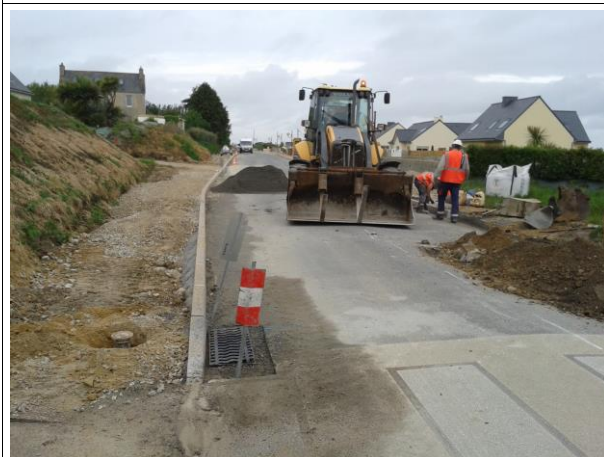
Pendant les travaux
