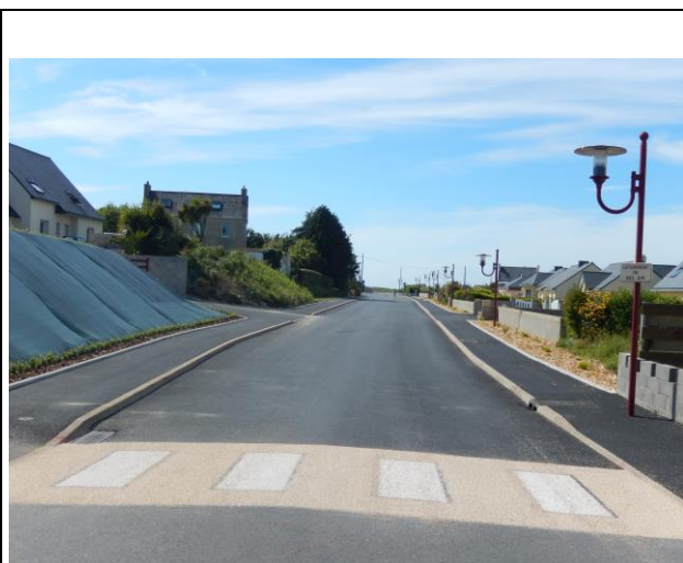
Route de Bel Air Sortie du centre bourg après travaux
