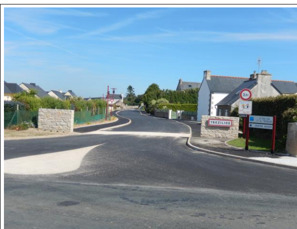
Rue Bel Air Entrée d'agglomération après travaux
